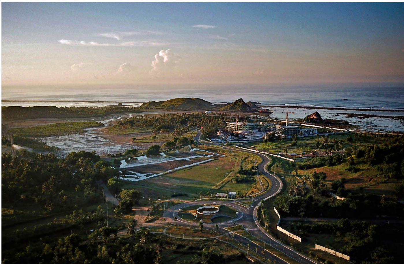
Foto udara memperlihatkan pembangunan arena balap motor dan infrastruktur turisme di Mandalika. (Photo by Arsyad Ali / AFP)
